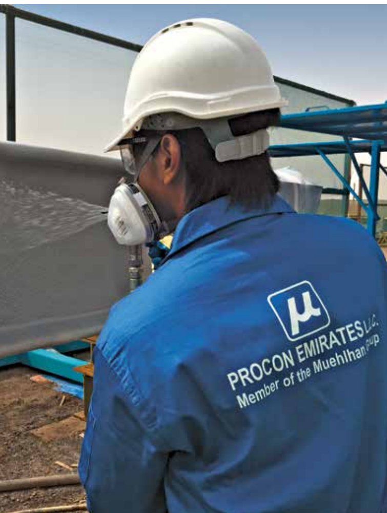
Aufbringen von Brandschutz auf Stahl
