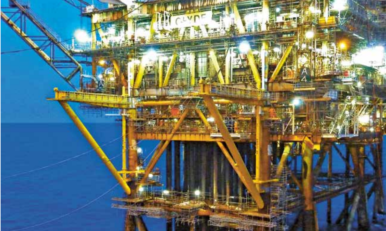
Ölförderplattform „Thistle“ in der Nordsee
