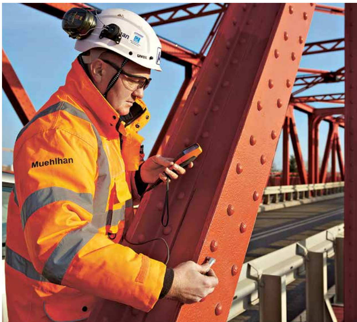
Überprüfung des Oberflächenschutzes einer Brücke
