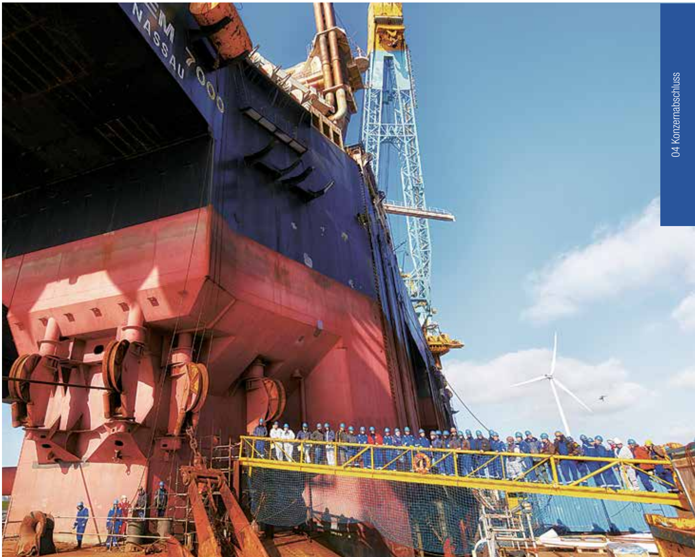
Tiefwasser Errichterplattform „Saipem 7000“, Eemshaven, Niederlande
