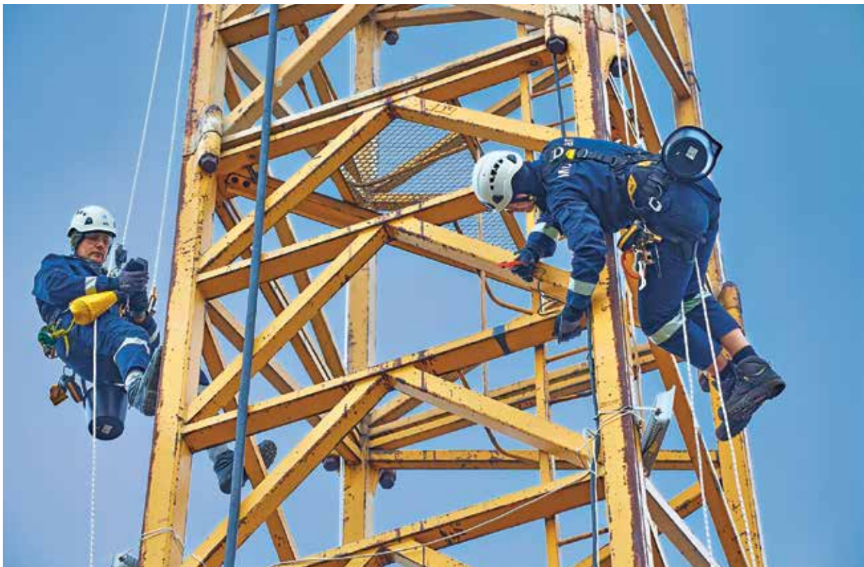
Zugangstechnik mit Seilkonstruktion
